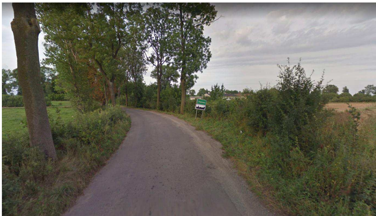
Zdjęcie 3. Droga wjazdowa do miejscowości Stalewo
