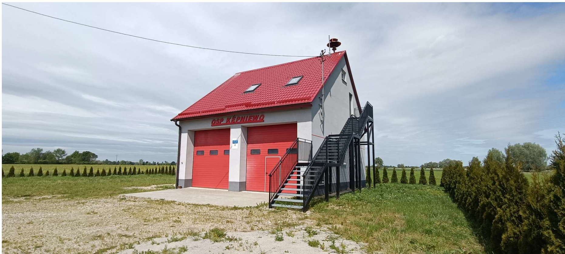
Budynek OSP w Kępnie
