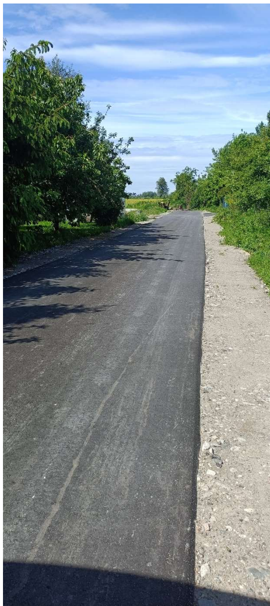
Droga asfaltowa w Żurawcu
