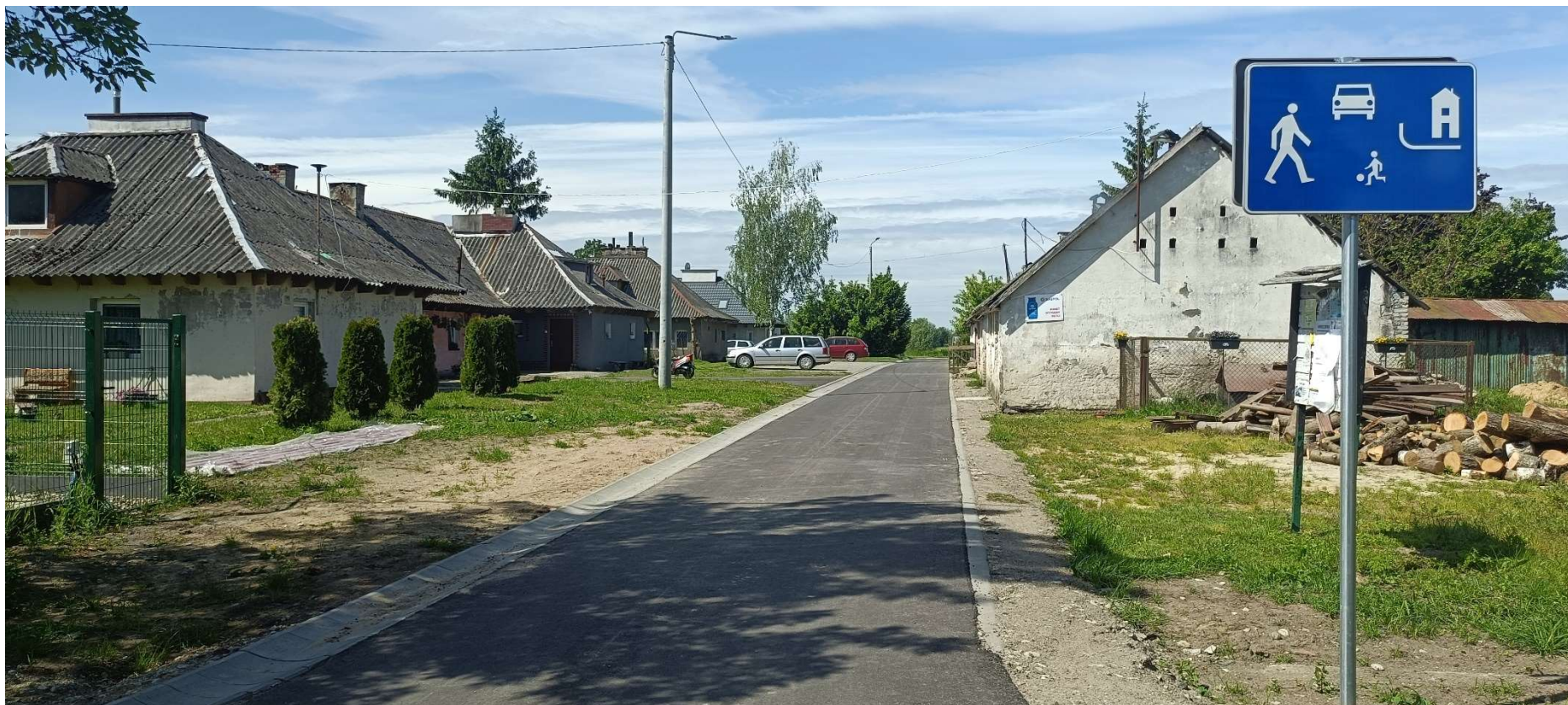
Droga asfaltowa na osiedlu w Żurawcu
