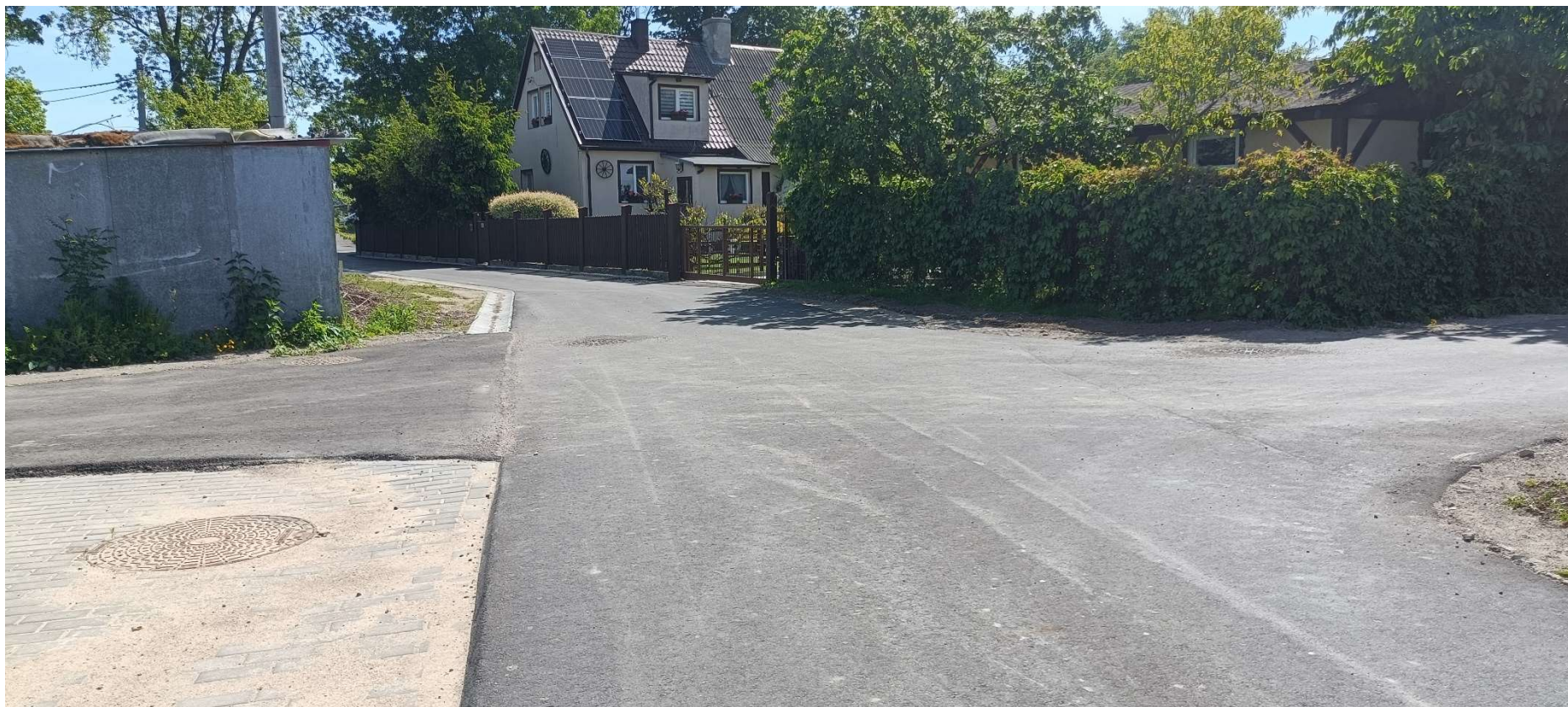
Droga asfaltowa na osiedlu w Żurawcu
