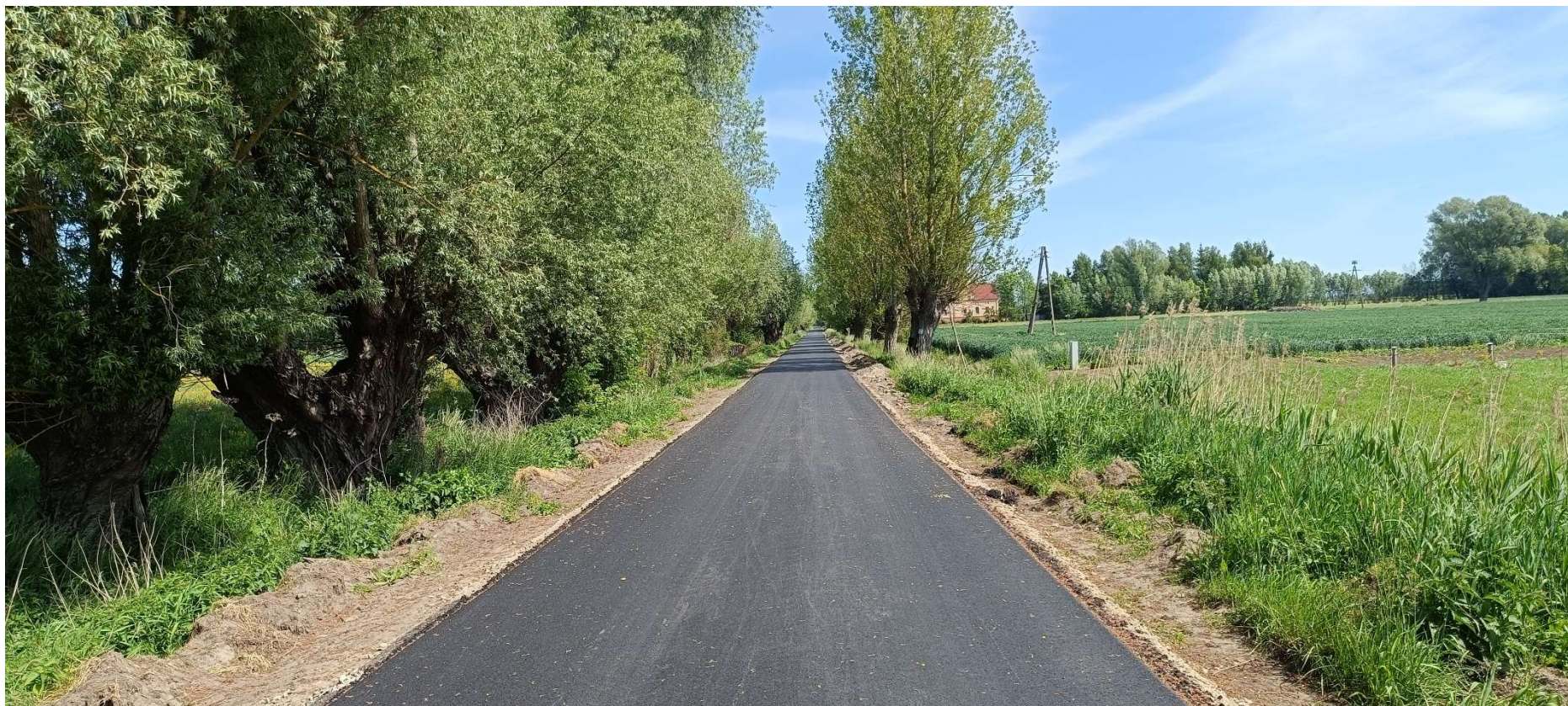
Droga w Nowym Dolnie
