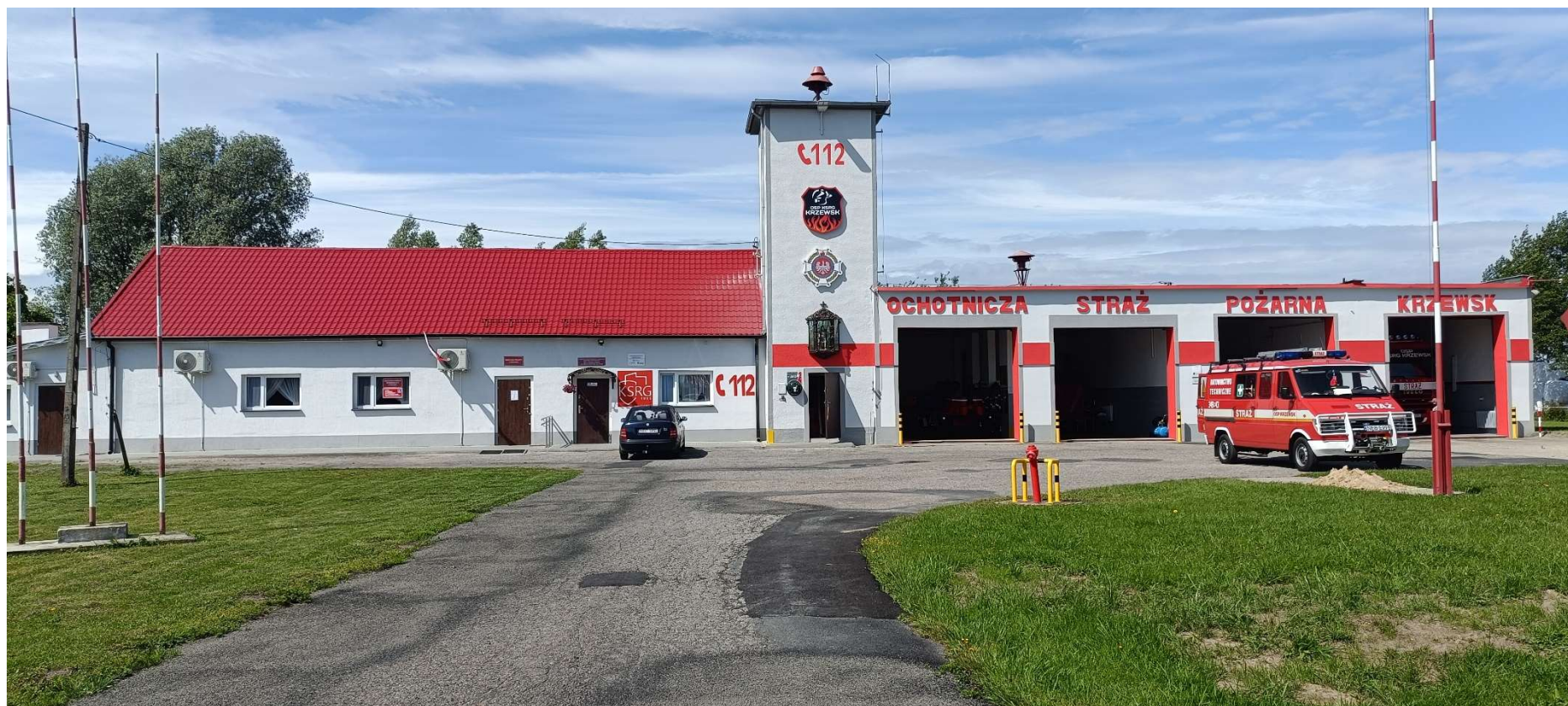
Budynek Ochotniczej Straży Pożarnej w Krzewsku
