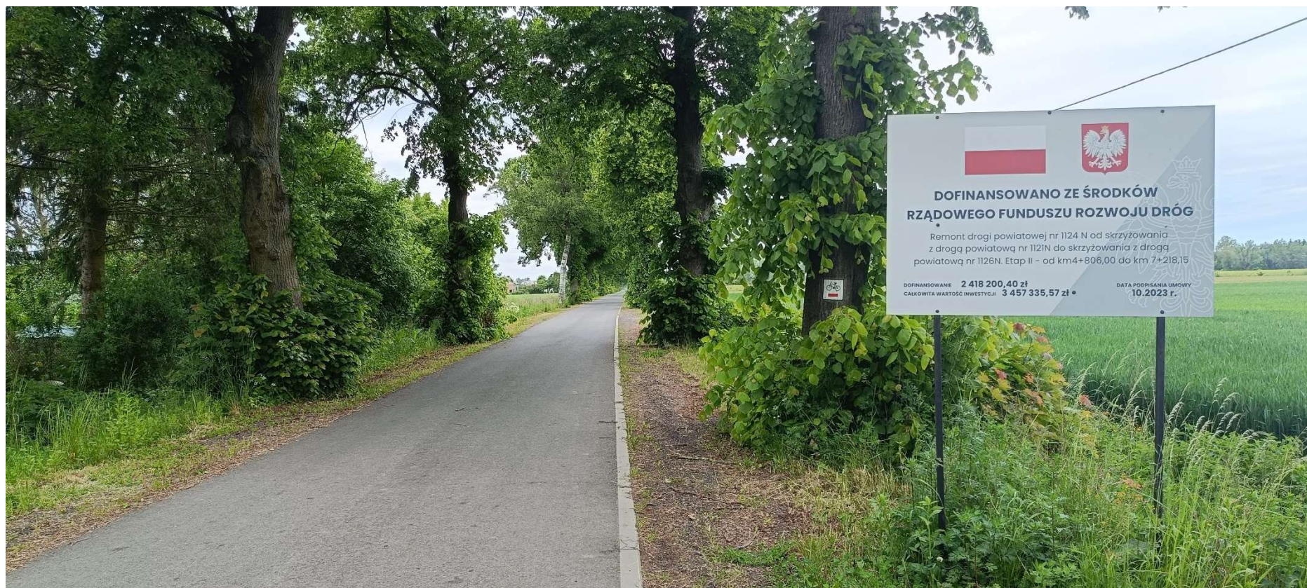
Droga asfaltowa w Zwierzeńskim Polu
