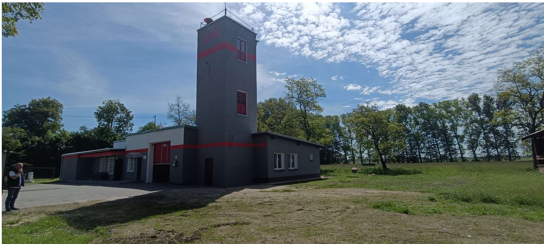
Budynek Ochotniczej Straży Pożarnej w Żurawcu
