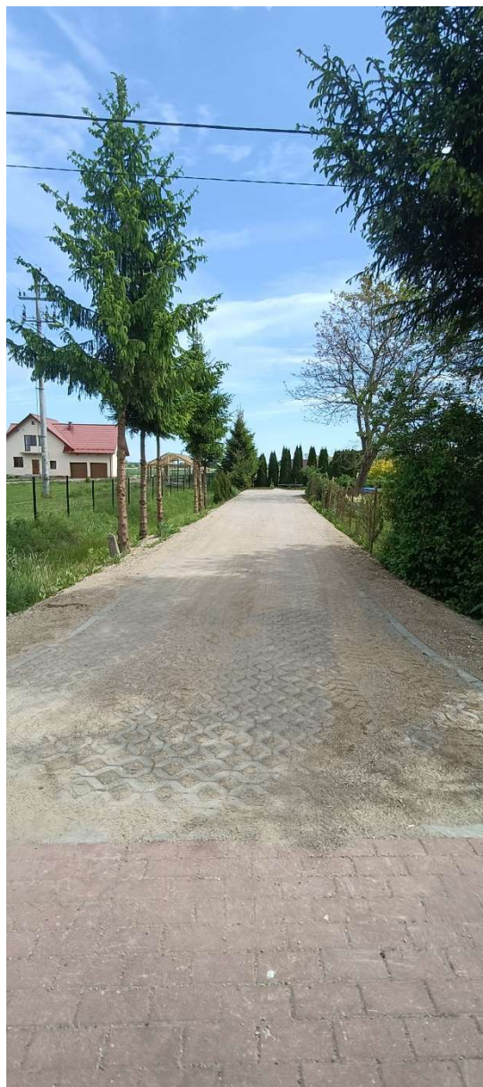
Utwardzone drogi wewnętrzne w Kępniewie
