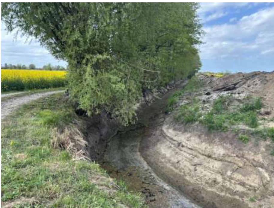
Rysunek 8 Prace przy udrażnianiu rowu melioracyjnego, źródło: opracowanie własne
