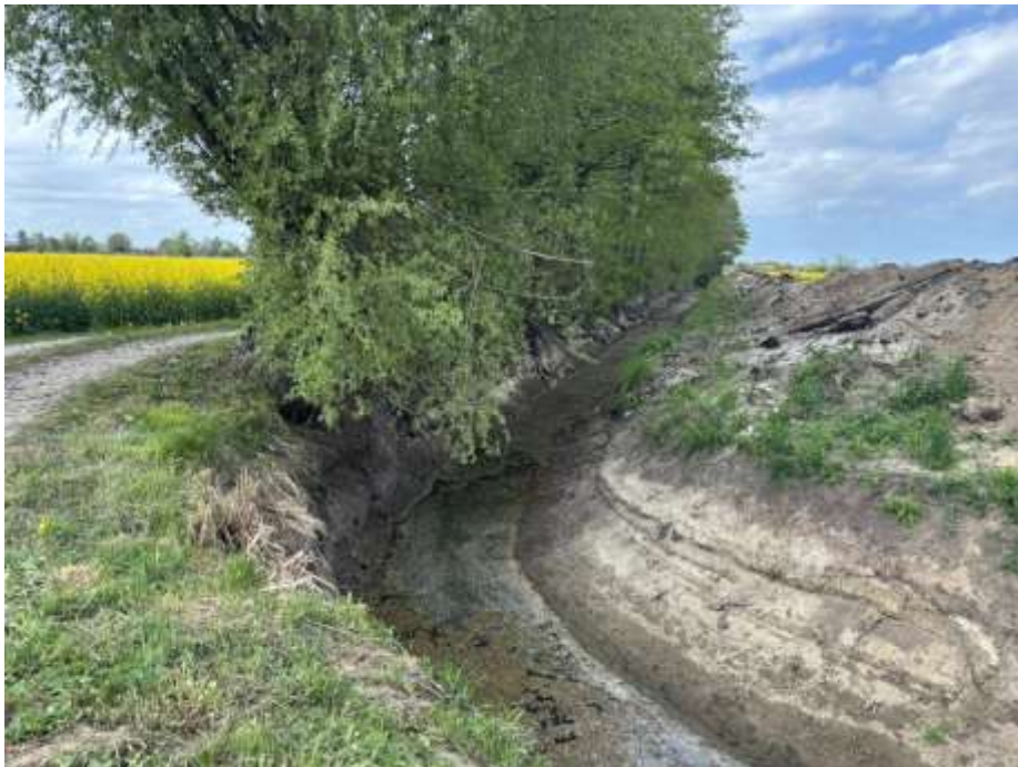
Rysunek 8 Prace przy udrażnianiu rowu melioracyjnego, fotografia - zasób własny
